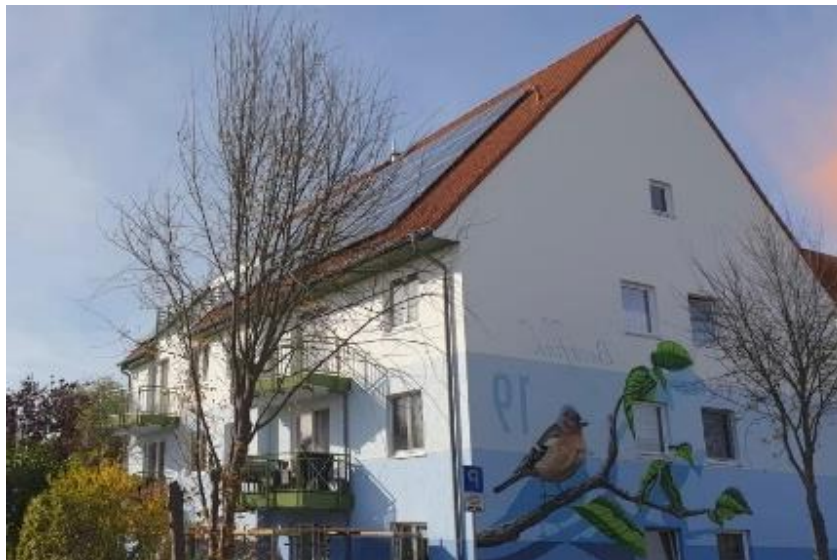
Abb. Fassadensanierung Finkenweg 17 u. 19, Wustermark OT Elstal
