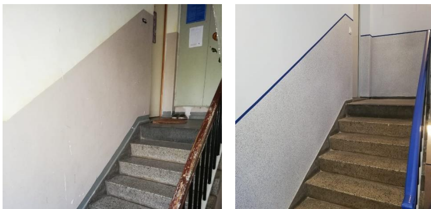
Abb. Treppenhaus vorher/nachher Am Umspannwerk 3a-c
